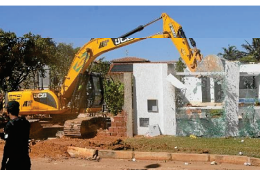
Demolições em Vicente Pires fizeram com que o assunto chegasse à CLDF
